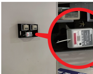
庁内に設置された CO 2 温湿度センサー端末 SGTHA-CO2
